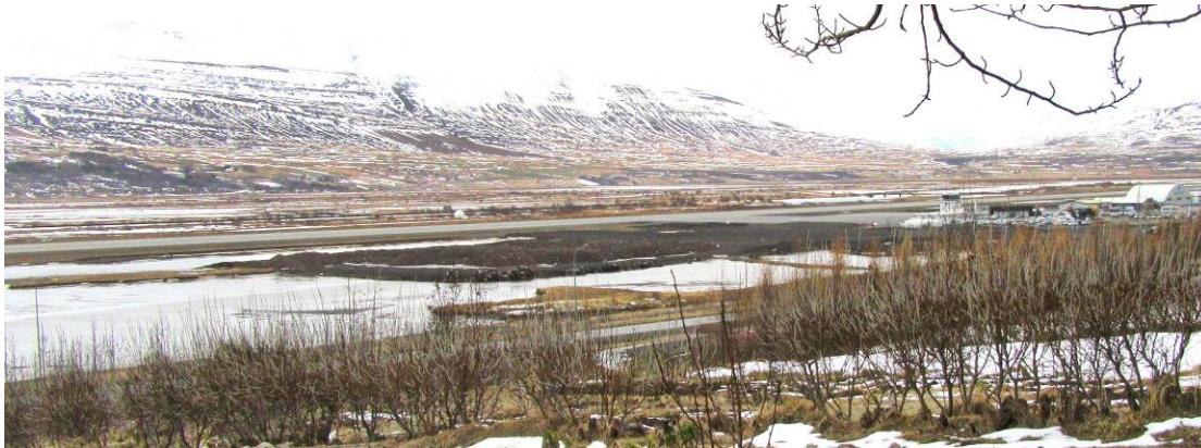
Mynd 4 Horft yfir efni úr Vaðlaheiðargöngum sem notað hefur verið sem farg þar sem nýtt flughlað Akureyrarflugvallar verður.
