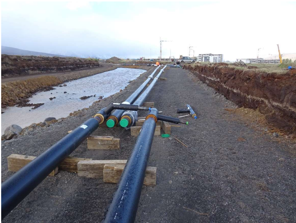
Mynd 4. Kjarnagata útlagning og samsetning hitaveitulagna. Tenging inn í Jónínuhaga í forgrunni.
