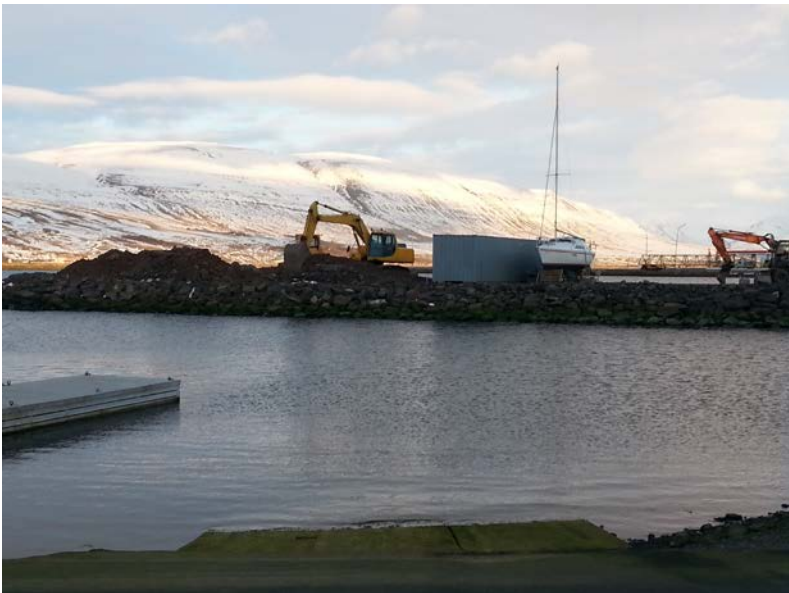
Mynd 3: Landfylling þar sem hús á að rísa
