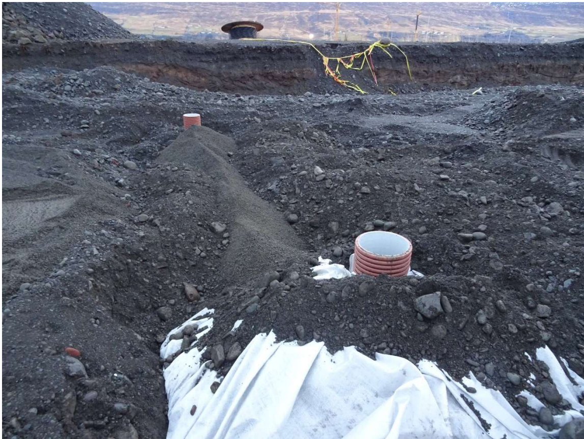
Mynd 5. Kjarnagata regnvatnsbrunnur, búið að koma púkki í kringum hann og klæða með dúk. Niðurfall í fjarska
