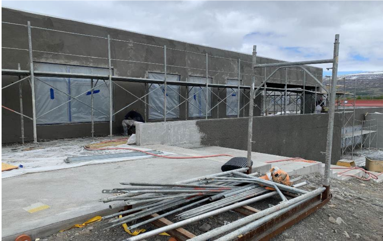
Unnið við múrverk í júní
